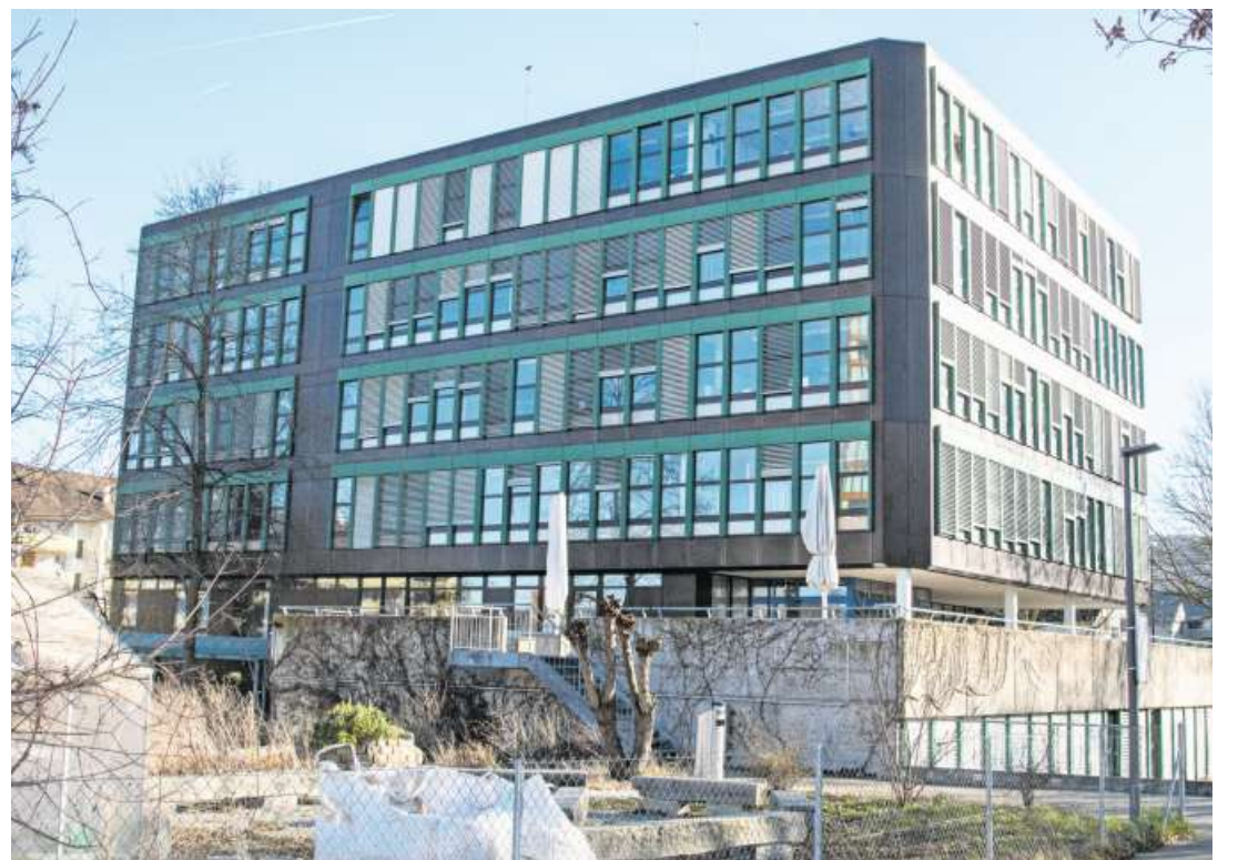
Das Gymnasium Muttenz befindet sich noch in gutem Zustand. Bild: Nicole Nars-Zimmer (Muttenz, 24.2.2020)
